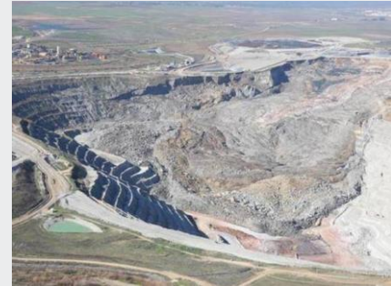
Derrumbe en Mina Las Cruces España – Ene 2019
